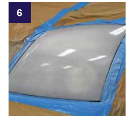
PRIMER APPLIZIERT Bild zeigt das Ergebnis, im nassen, milchigen, weißen Zustand
